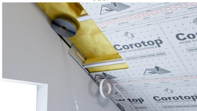
5. Alle technischen Übergänge (z.B. Leitungen, Rohre usw.) sind sorgfältig mit speziellen Klebstoffen oder Klebebändern (z.B. Corotop FIX, MIX) abzudichten.
