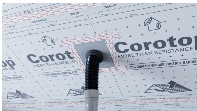
Es wird empfohlen, eine zusätzliche Druckleiste zu verwenden. Um die Auswirkungen von Konstruktionsspannungen zu beseitigen, wird empfohlen, ca. 2 cm überschüssige Folie (Falte) an der Wand zu lassen. (Anhang Nr. 1)
